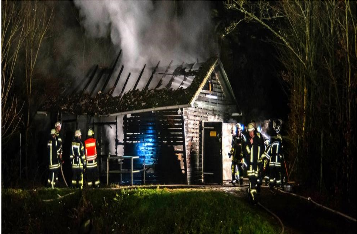
Die Feuerwehrleute im Einsatz an der Kläranlage in Hohenstein-Hennethal. Bild © Robin von Gilgenheimb...
